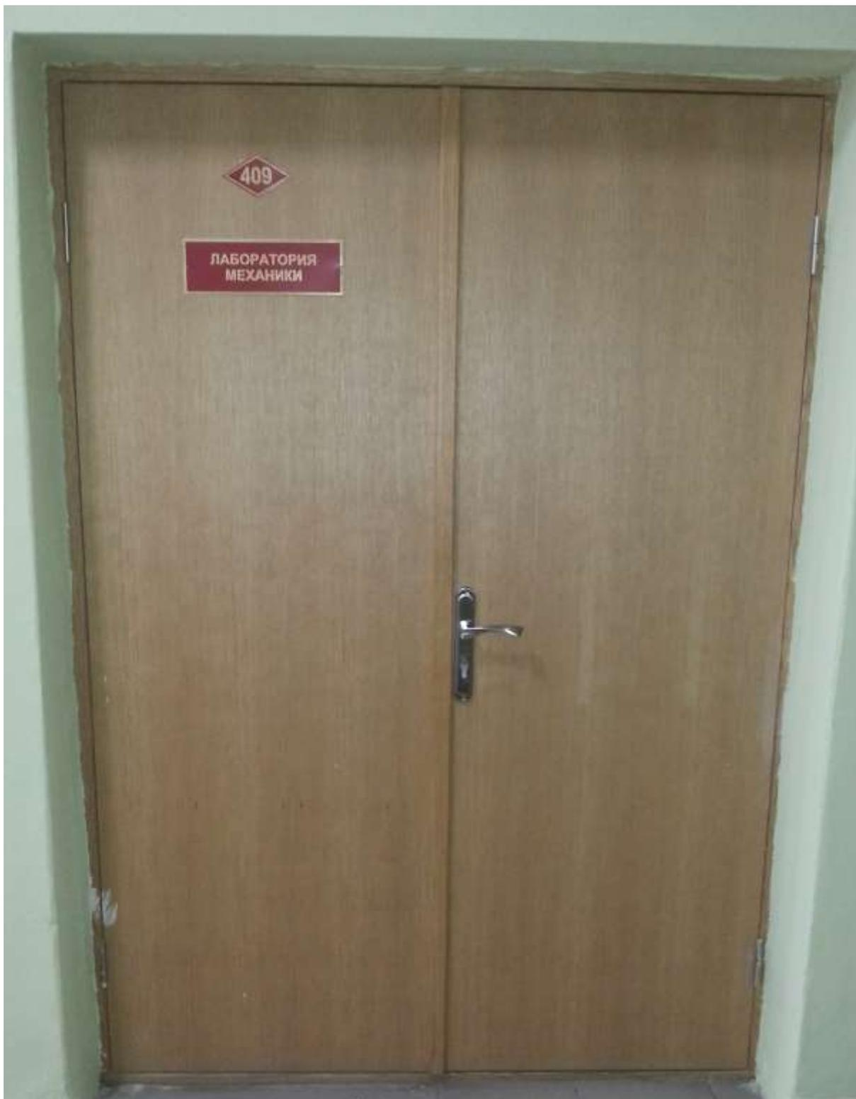
Рис. 3 – Дверной блок (щитовой шпонированный)
