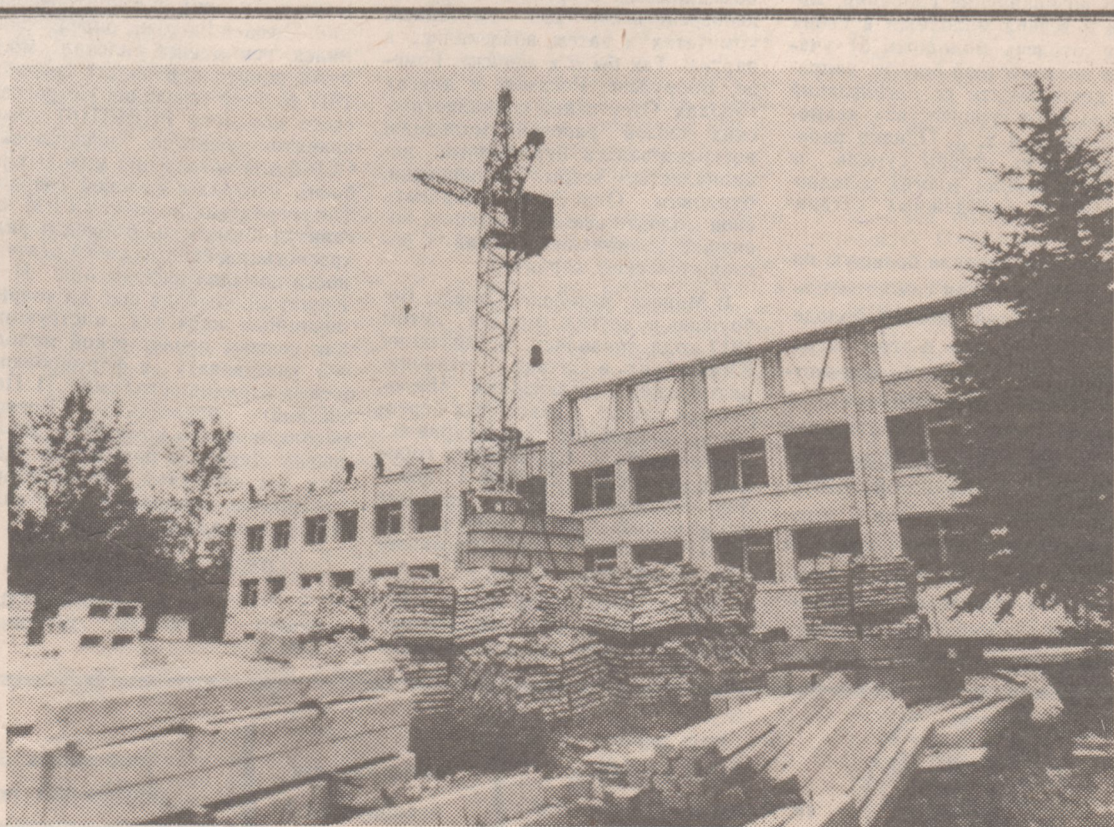
СТРОИТСЯ НОВЫЙ КОРПУС БИОФАКА.
