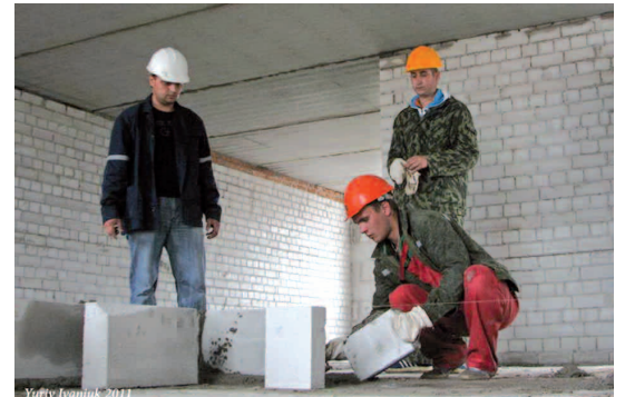
Yuriy Ivanuk 2011 Бойцы строительного отряда на строительстве жилого дома
